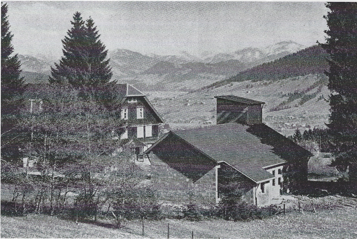
Rohbau der Schutzengelkapelle, Nordwestansicht (1961)
